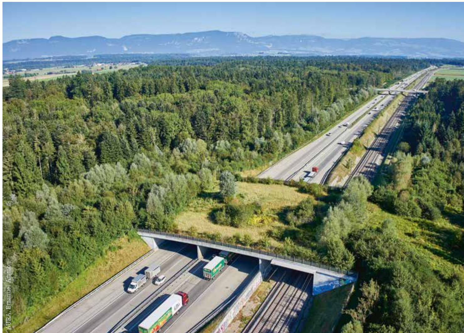
Wildtierbrücke / Passage pour la faune sauvage / Ponte per la selvaggina
